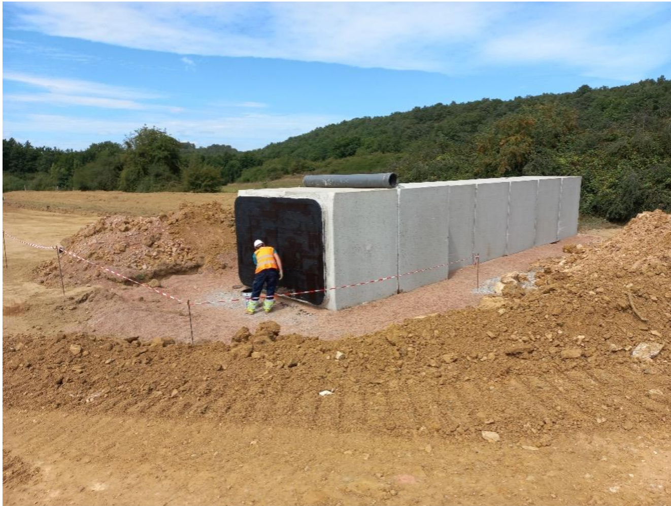
Réalisation du merlon paysager avec pose de la galerie souterraine pour chiroptères
