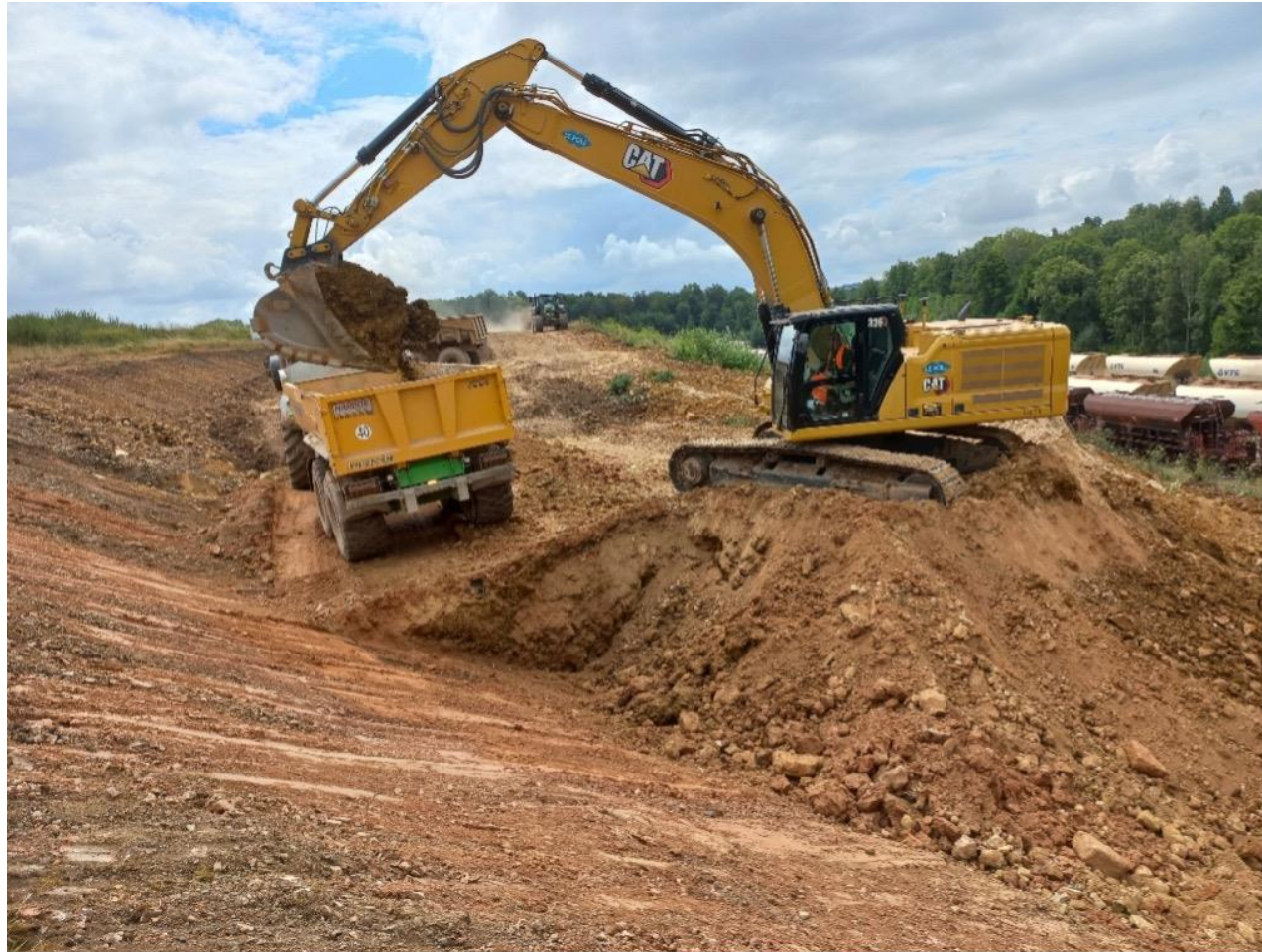
Extraction des matériaux issus du terrassement de l'extension du plateau fer
