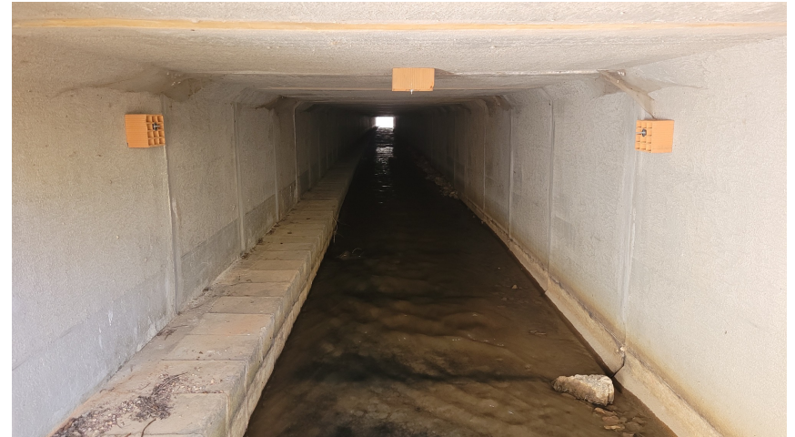
Aménagement d'un tunnel
