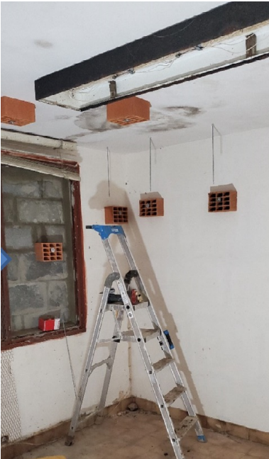
Restauration d'un gîte
